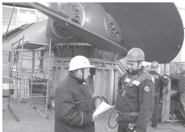
Ведущий инженер-инспектор Александр Дерюшев (слева) на монтажной площадке Воткинской ГЭС проверяет схему строповки рабочего колеса гидроагрегата №5
